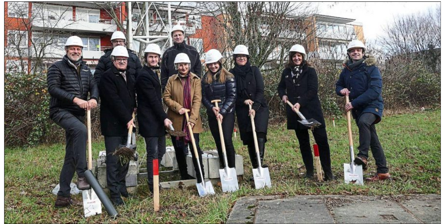
GEMEINSAMER SPATENSTICH: OB Hubert Schnurr (Zweiter von links) mit Mitgliedern der Investorenfamilie (Mitte) und Vertretern der projektbeteiligten Firmen beim offiziellen Auftakt des Bauprojekts am Henri-Dunant-Platz. Foto: König
